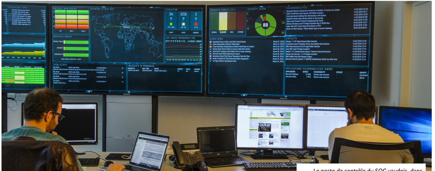
Le poste de contrôle du SOC vaudois, dans l'Ouest lausannois. © Eddy Mottaz
